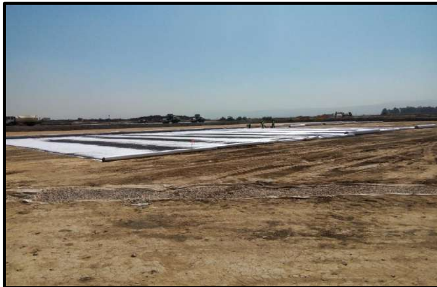
Figure 5 : Mise en place Géotextile
