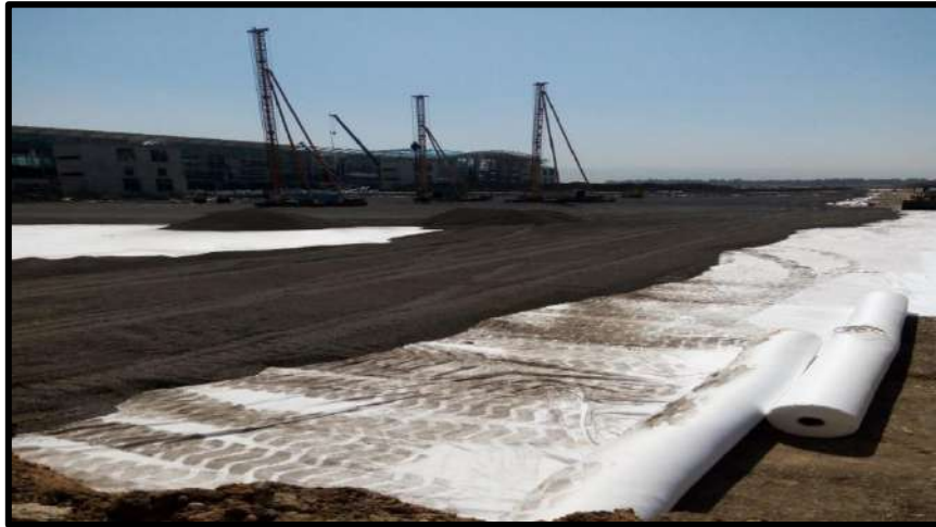
Figure 6 : Mise en œuvre de la couche drainante
